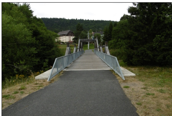
Lávka 5d-L1 - staničení 0,066 - celkový pohled
