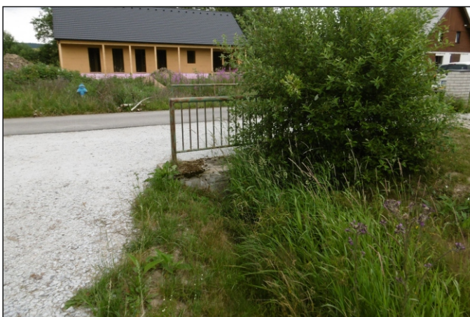
Propustek 4d - staničení 0,018 - pohled zprava
