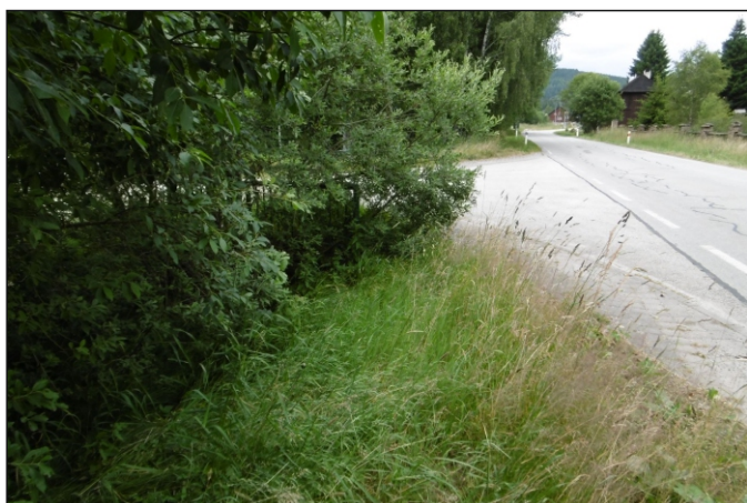
Propustek 16c - staničení 0,004 - pohled zleva
