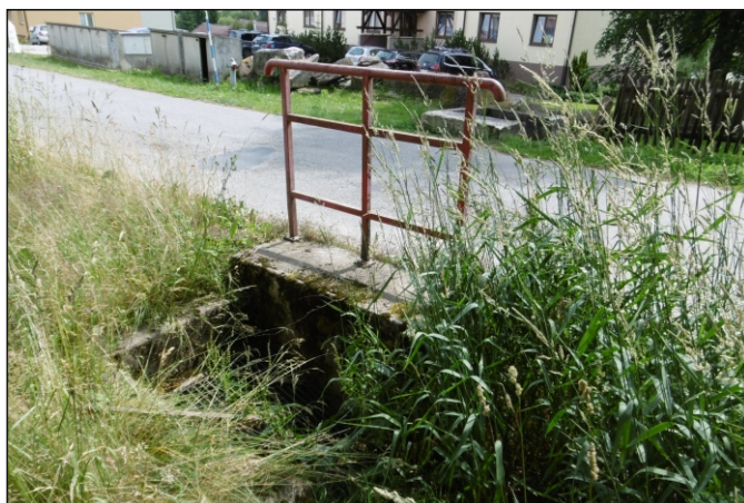
Propustek 7c - staničení 0,139 - pohled zprava
