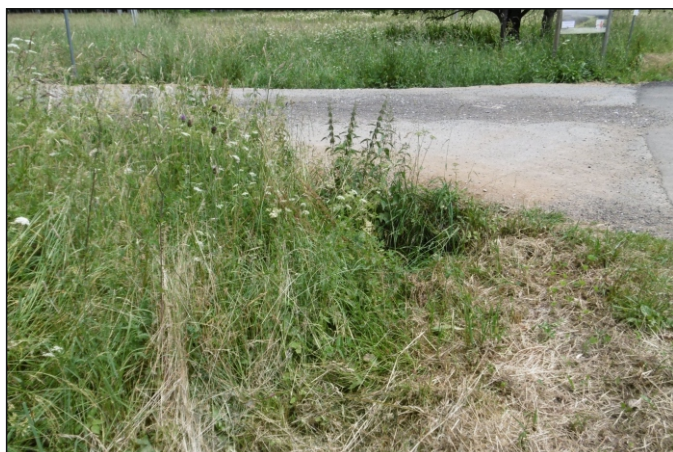
Propustek 17c - staničení 0,002 - pohled zleva
