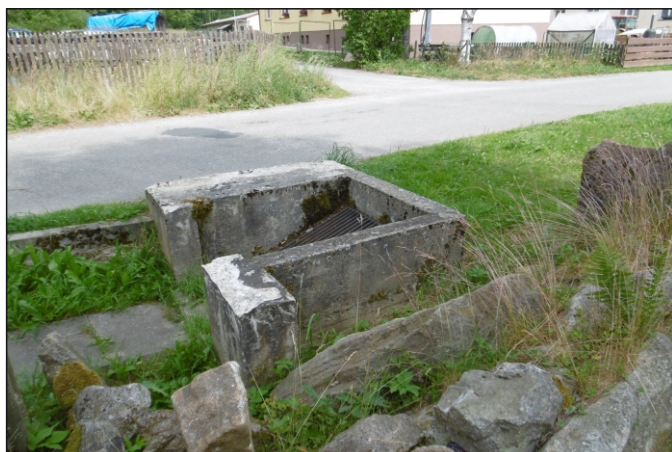
Propustek 7c - staničení 0,139 - pohled zleva
