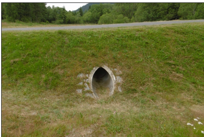
Propustek 5d - staničení 0,119 - pohled zleva
