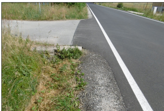
Propustek 2c - staničení 0,001 - pohled zleva
