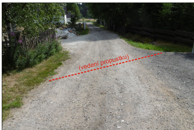
Propustek 1c - staničení 0,072 - celkový pohled
