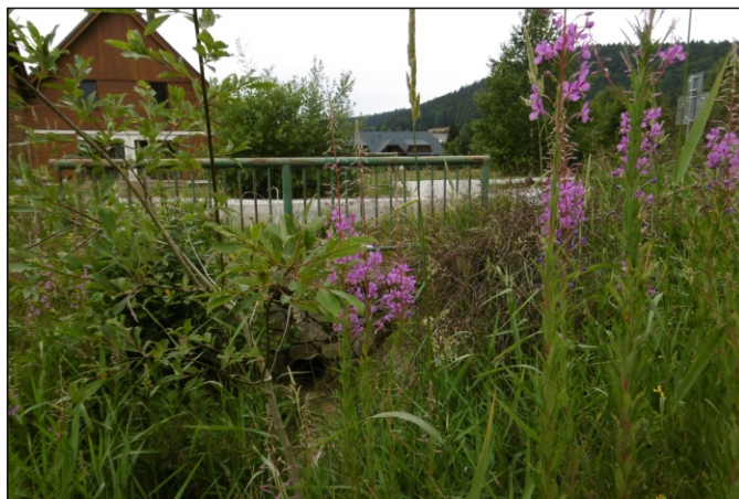
Propustek 4d - staničení 0,018 - pohled zleva
