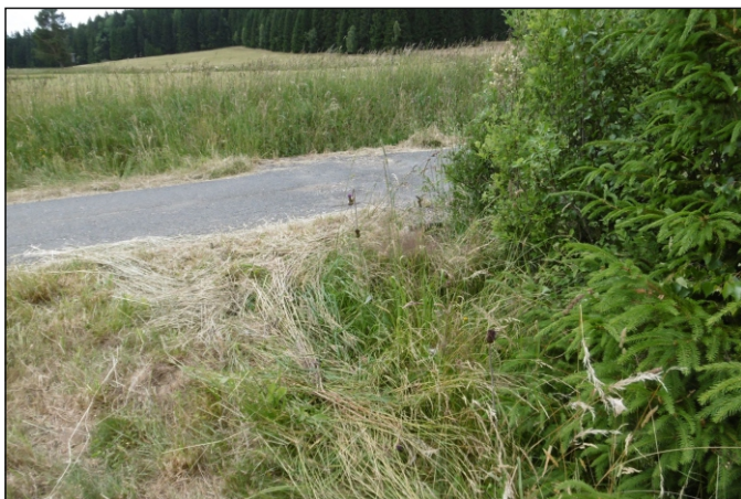
Propustek 17c - staničení 0,542 - pohled zprava
