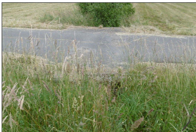
Propustek 17c - staničení 0,542 - pohled zleva
