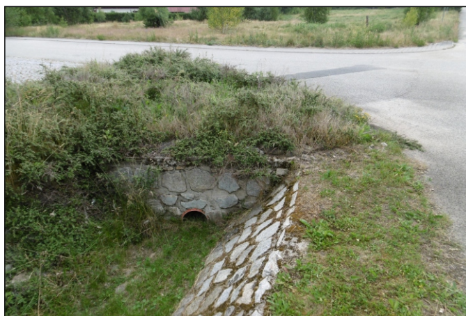
Propustek 15c - staničení 0,274 - pohled zprava
