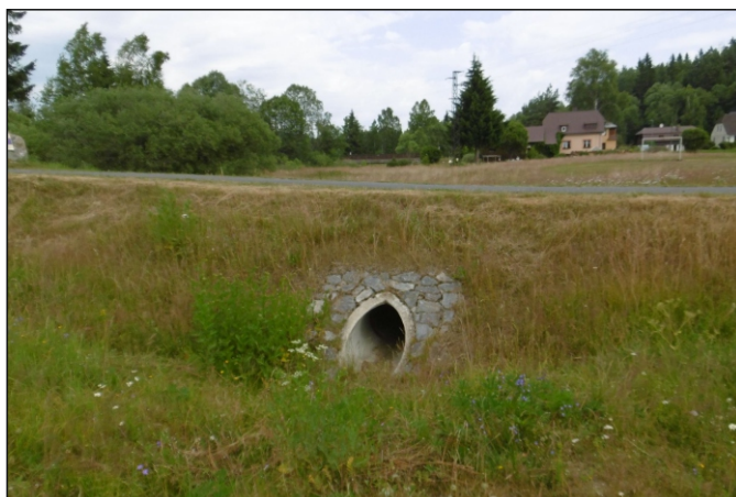
Propustek 5d - staničení 0,119 - pohled zprava
