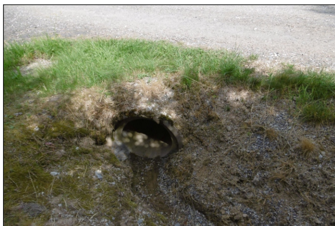
Propustek 1c - staničení 0,072 - pohled zleva
