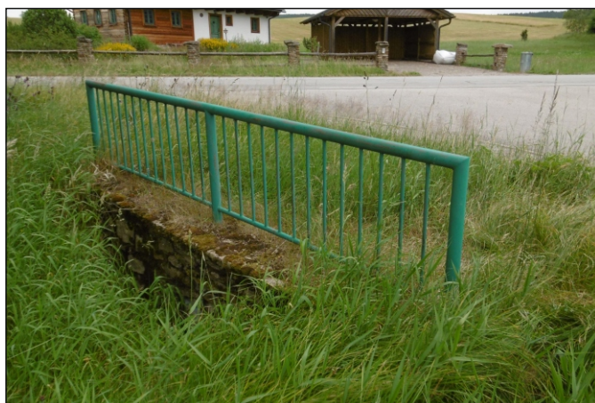
Propustek 16c - staničení 0,004 - pohled zprava
