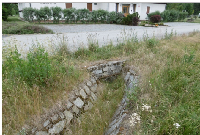
Propustek 15c - staničení 0,274 - pohled zleva
