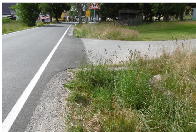
Propustek 2c - staničení 0,001 - pohled zprava
